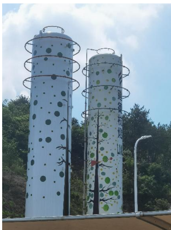
LNG 立式真空粉末绝热罐
